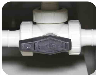
2-Wege-Kugelhahn zur Auswahl der Flüssigkeitsabfuhr: Abfluss/Sammeltank
